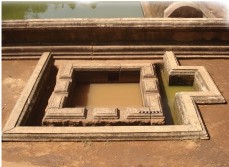
රූපය 1.12 කුට්ටම් පොකුණේ ජල පෙරනයක් (මෙහි පිටත කාණුවට ලැබෙන ජලය මැද කොටුවේ තබා ඇති කපොලු හය තුළින් ඇතුළට යැවේ. ඇතුළත කොටුවේ සිට නළයක් මගින් එම ජලය පොකුණට යැමට සලස්වා ඇත.)
