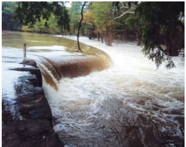
රූපය 1.7 මල්වතු ඔයේ ස්වාභාවික ගල් තලාව මත වේල්ලක් බැඳ නිර්මාණය කෙරුණු තේක්කම් අමුණ (වම්පස) එම අමුණ ජලයෙන් පිරුණු පසු පිටාර ගලන අයුරු (දකුණු පස)
