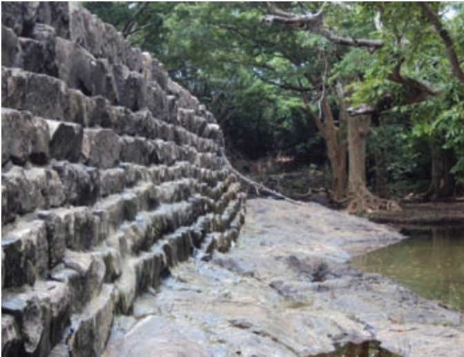
රූපය 1.7 මල්වතු ඔයේ ස්වාභාවික ගල් තලාව මත වේල්ලක් බැඳ නිර්මාණය කෙරුණු තේක්කම් අමුණ (වම්පස) එම අමුණ ජලයෙන් පිරුණු පසු පිටාර ගලන අයුරු (දකුණු පස)
