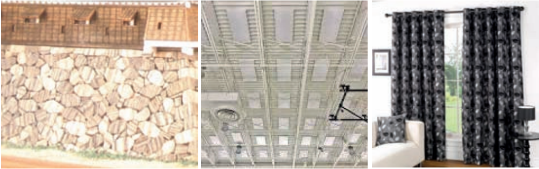
බිත්ති රළ කිරීම සිදුරු සහිත වහල ආවරණ යෙදීම රළ තිර රෙදි යෙදීම 14.23 රූපය - ප්‍රතිනාදය වැළැක්වීමට යොදාගෙන ඇති උපක්‍රම
