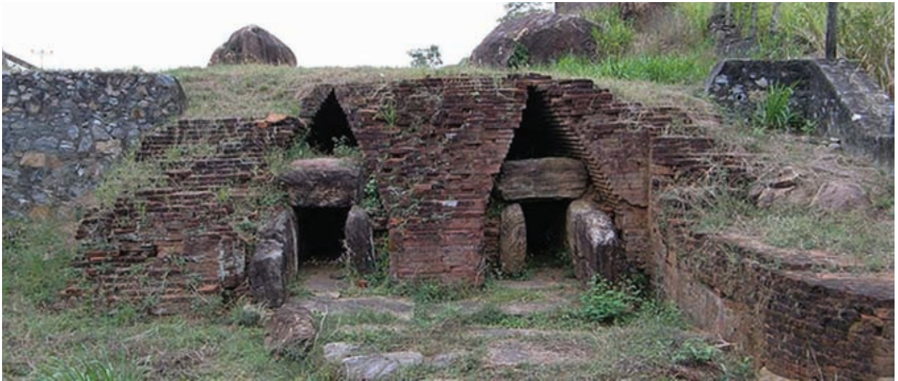
ඡායාරූපය අංක 5.3 වර්තමාන මාදුරුමය ජලාශයේ වේල්ලේ සොරොව්ව ඉදි කිරීමට සුදුසු තැනක් විදේශික ඉංජිනේරුවරුන් විසින් පරීක්ෂා කොට හඳුනාගත් තැන අපේ පැරණි ඉංජිනේරුවන් විසින් ඊට අවුරුදු සිය ගණනකට ඉහත කාලයක දී සොරොව්වක් ඉදි කර තිබිණි. මේ එම පැරණි සොරොව්ව නටබුන් වී තිබී මතුකර ගත් පසු අවස්ථාවයි.
