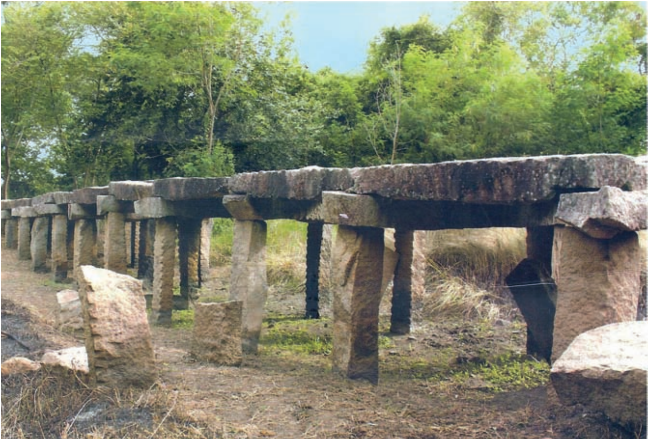
ඡායාරූපය අංක 5.2 අනුරාධපුරයේ සිට විහිදෙන මහාමාර්ග පද්ධතියක් එකල තිබිණි. අනුරාධපුරය හරහා ගලා බසින මල්වතුමය හරහා ගමන් කිරීමට එකල මහාමාර්ග ඉංජිනේරුවෝ කළුගලින් පාලම් තැනූහ. පාලම් තැනීමේ මූලික විද්‍යාත්මක සිද්ධාන්ත ඔවුන් දැන සිටි බව ඉන් පැහැදිලි වෙයි. මේ ඵලෙස තැනූ ගල් පාලමක් නටබුන් ව තවමත් සුරැකී තිබෙන අන්දම යි.
