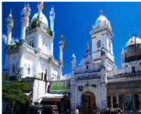
3.15 රූපය - කොළඹ දවටගහ මුස්ලිම් පල්ලිය
