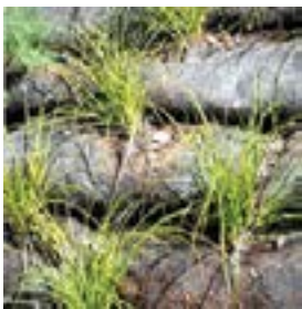
බැවුම හරස් කරමින් පස් පිරවූ ගෝනි තබා එම ගෝනි සිදුරු කර පැළ සිටුවීම
