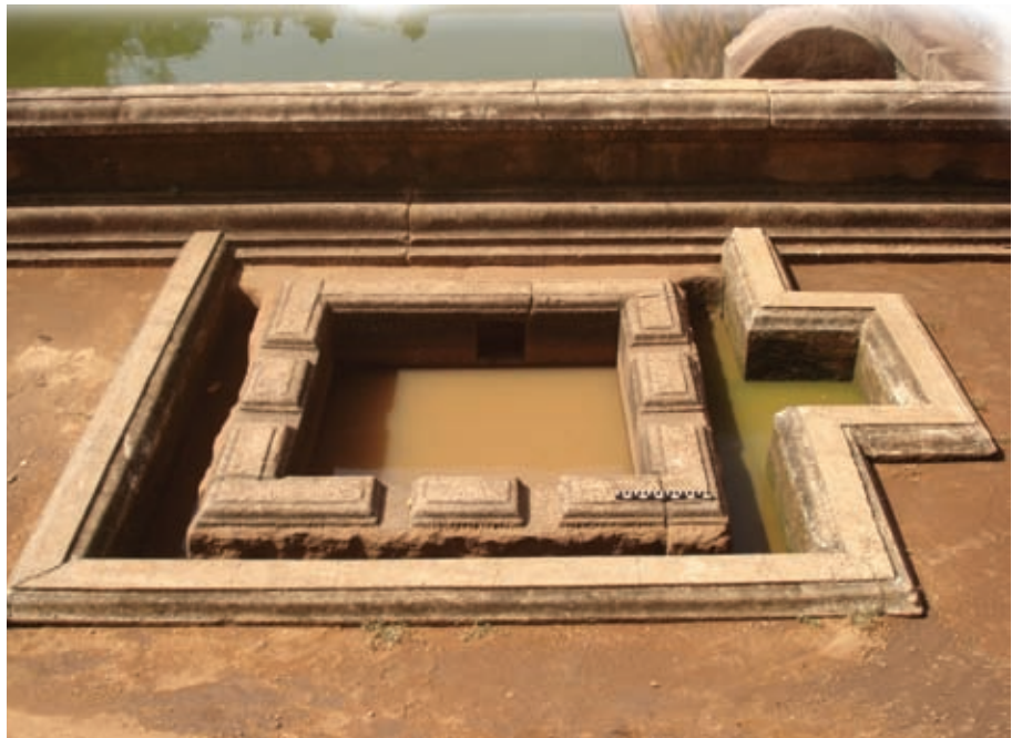
රූපය 1.12 කුට්ටම් පොකුණේ ජල පෙරනයක් (මෙහි පිටත කාණුවට ලැබෙන ජලය මැද කොටුවේ තබා ඇති කපොලු හය තුළින් ඇතුළට යැවේ. ඇතුළත කොටුවේ සිට නලයක් මගින් එම ජලය පොකුණට යැමට සලස්වා ඇත.)
