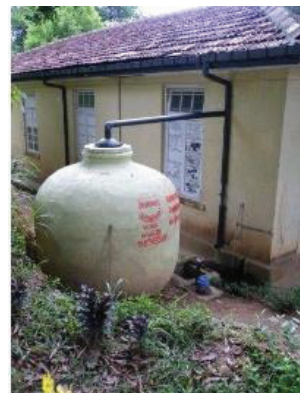
15.7 රූපය ▲ නිවෙසක වැසි ජලය රැස් කිරීමට යොදා ඇති උපක්‍රමයක්
