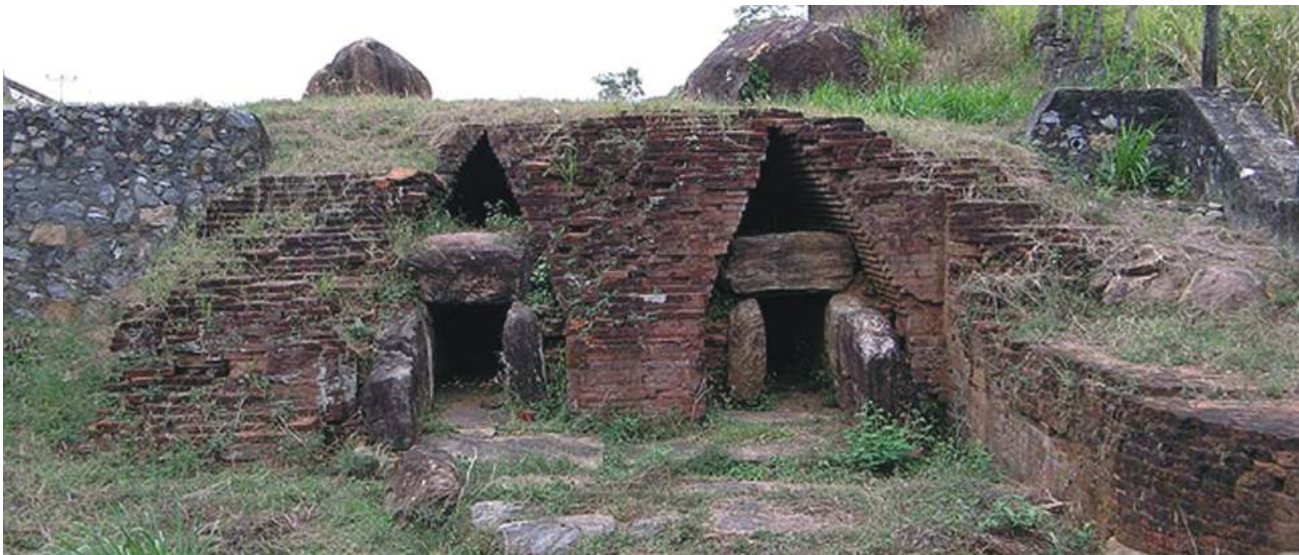
ඡායාරූපය අංක 5.3 වර්තමාන මාදුරුඔය ජලාශයේ වේල්ලේ සොරොච්ච ඉදි කිරීමට සුදුසු තැනක් විදේශික ඉංජිනේරුවරුන් විසින් පරීක්ෂා කොට හඳුනාගත් තැන අපේ පැරණි ඉංජිනේරුවන් විසින් ඊට අවුරුදු සිය ගණනකට ඉහත කාලයක දී සොරොච්චක් ඉදි කර තිබිණි. මේ එම පැරණි සොරොච්ච නටබුන් වී තිබී මතුකර ගත් පසු අවස්ථාවයි.
