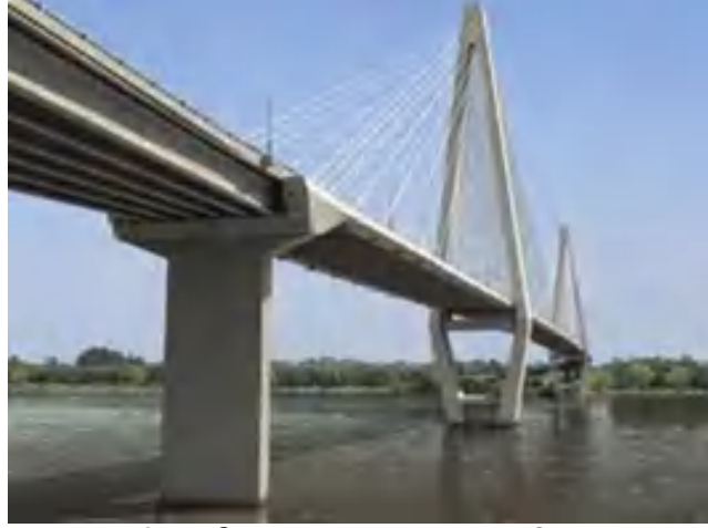
உரு 2.8 இழுவிசை, நெருக்குதல் ஆகிய இரு சக்திகளுக்கும் தாக்குப் பிடிக்கக்கூடியவாறு அமைக்கப்பட்ட பாலம்
