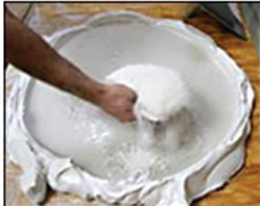
3.40 රූපය - දියකළ හුණු, ගෝනියක් මතට පෙරා සනවීමට සැලැස්වීම
