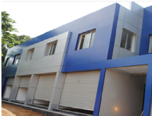
3.41 රූපය - ඇලුමිනියම් ක්ලැඩින් බෝඩ් භාවිතයෙන් නිමහම් කළ ගොඩනැගිල්ලක්
