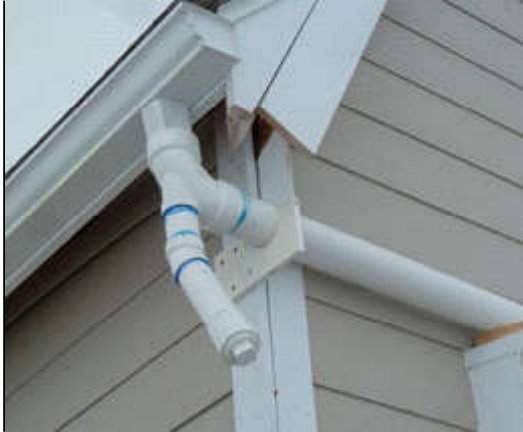
බැහැර නළය (Flush pipe)
