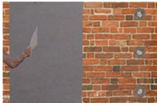
4.28 රූපය සිරස් කැට අතර බදාම පුරවා මට්ටම් කිරීම (මාල සකස් කිරීම)
