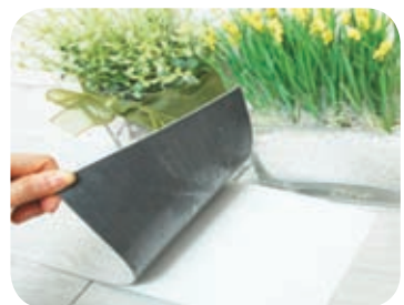
4.43 රූපය පී.වී.සී. උළු ගෙබිම ඇළවීම
