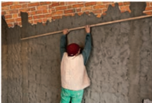
4.27 රූපය මාල දෙකක් අතර බදාම පුරවා මට්ටම් ලිය භාවිතයෙන් මට්ටම් කිරීම
