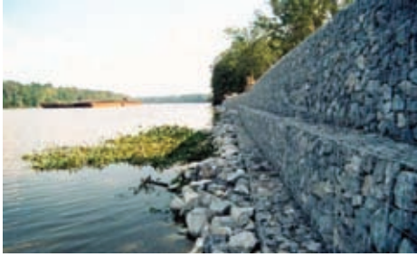
உரு 2.65 ஆற்றங்கரைகள் அரிக்கப்படுவதைத் தடுப்பதற்கான கட்டு
