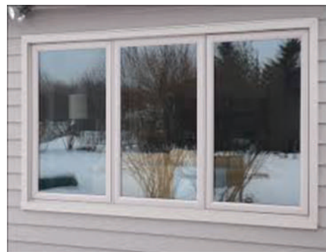
2.80 රූපය - රූවන ජනේල (Sliding window)
