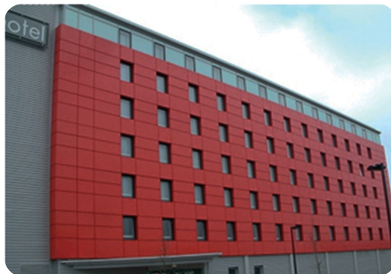
4.35 රූපය - ඇලුමිනියම් කැලැඬින් භාවිතයෙන් නිමහම් කරනු ලැබූ ගොඩනැගිල්ලක්
