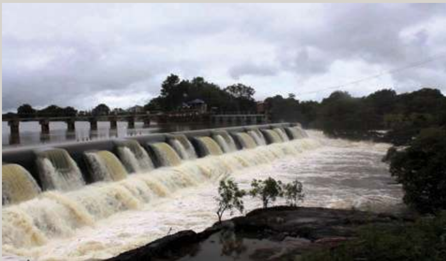
Fig:1.6 Inner spill and outer spill
